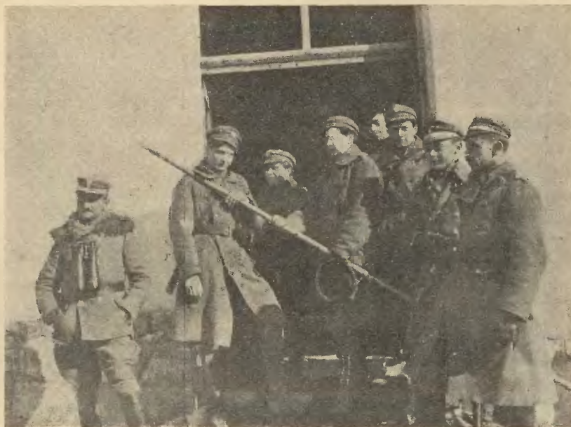
NA PUNKCIE OBSERW. W BETONIARNI
