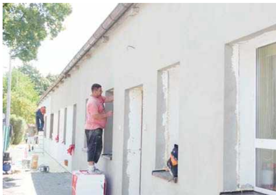
Przedszkolna Dwunastka wkrótce będzie bardzo kolorowa. Prace na obiekcie postępują w błyskawicznym tempie.
