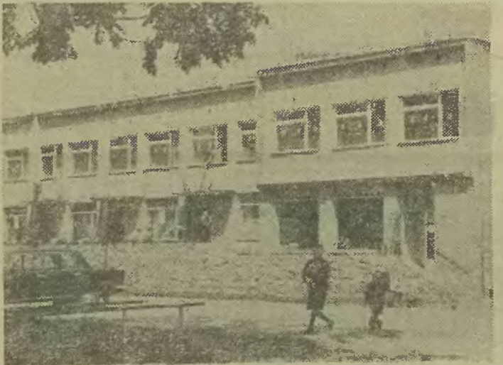
W domu gminnym w Dębowcu, w którym znajdują się pomieszczenia administracji terenowej, ośrodek zdrowia, sklep spożywczy, salki Koła Gospodyń Wiejskich, otwarty zostanie klub rolnika.
