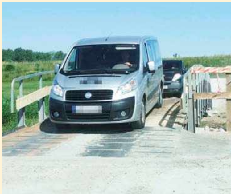
Tymczasowa droga po dnie kanału ulgi jest równiejsza, niż wiele dróg lokalnych
