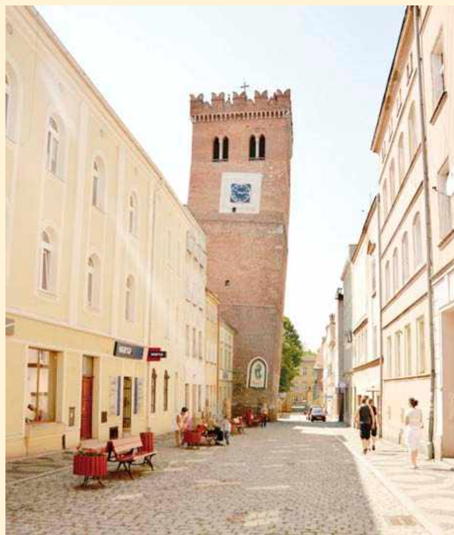
Odchylenie wieży w Ząbkowicach Śl. od pionu wynosi 2,14 m i nadal rośnie.
