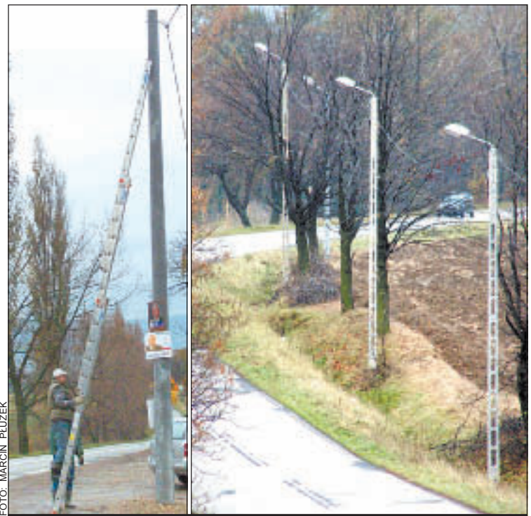
Trwa montaż latarni przy bielskiej ulicy Wyzwolenia.
