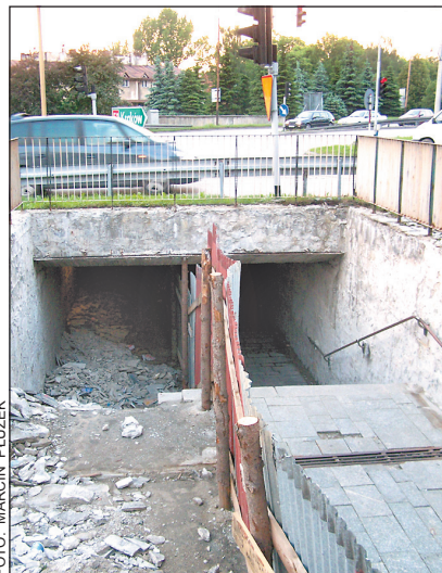
Remontowanego przejścia pod ulicą Lwowską nie wyłączono z ruchu.
