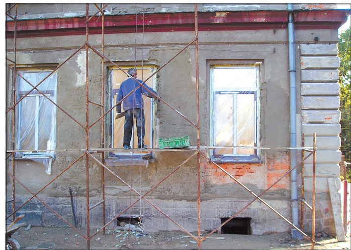
W Powiatowym Domu Dziecka w Żywcu wreszcie rozpoczął się remont elewacji.
