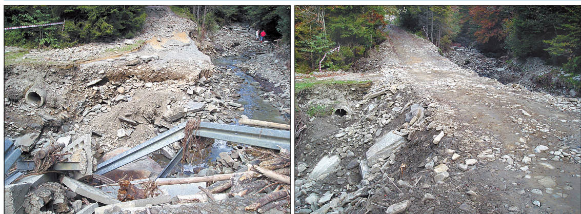
Droga w Kocierzu Moszczanickim prowadząca do przysiółka Wysokie tuż po powodzi i po prowizorycznej odbudowie.
