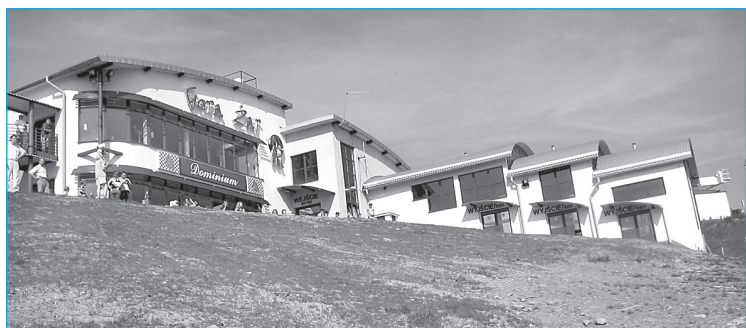
Szczyt Żaru staje się miejscem coraz bardziej zabudowanym.
