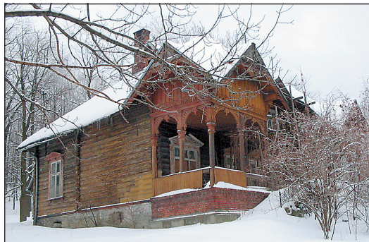
Ciągle coś przeszkadza w rozpoczęciu remontu leśniczówki.
