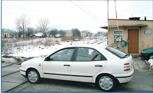
Zarzecze. Wjeżdżającemu na przejazd kierowcy widoczność z prawej strony ogranicza nagle budynek dróżnika.
