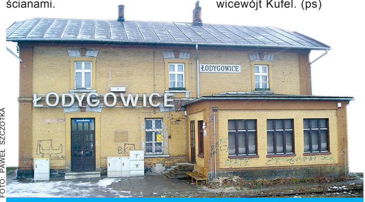
FOTO: PAMEL SZCZOTKA - Budynek stacji niszczeje, a PKP nie reagują! - martwią się mieszkańcy Łodygowic.
