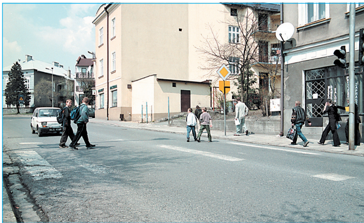
Oznakowanie przejść dla pieszych, jak tego w pobliżu SP nr 1, pozostawia wiele do życzenia...
