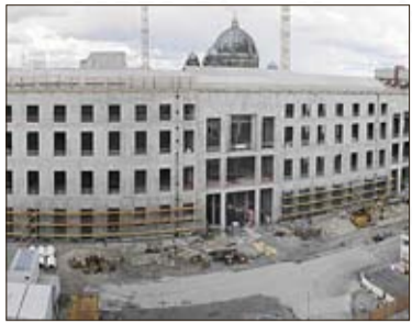
Elewacja obiektu w stanie surowym berlinschloss-webcam.de - zrzut ekranowy z 4 kwietnia
