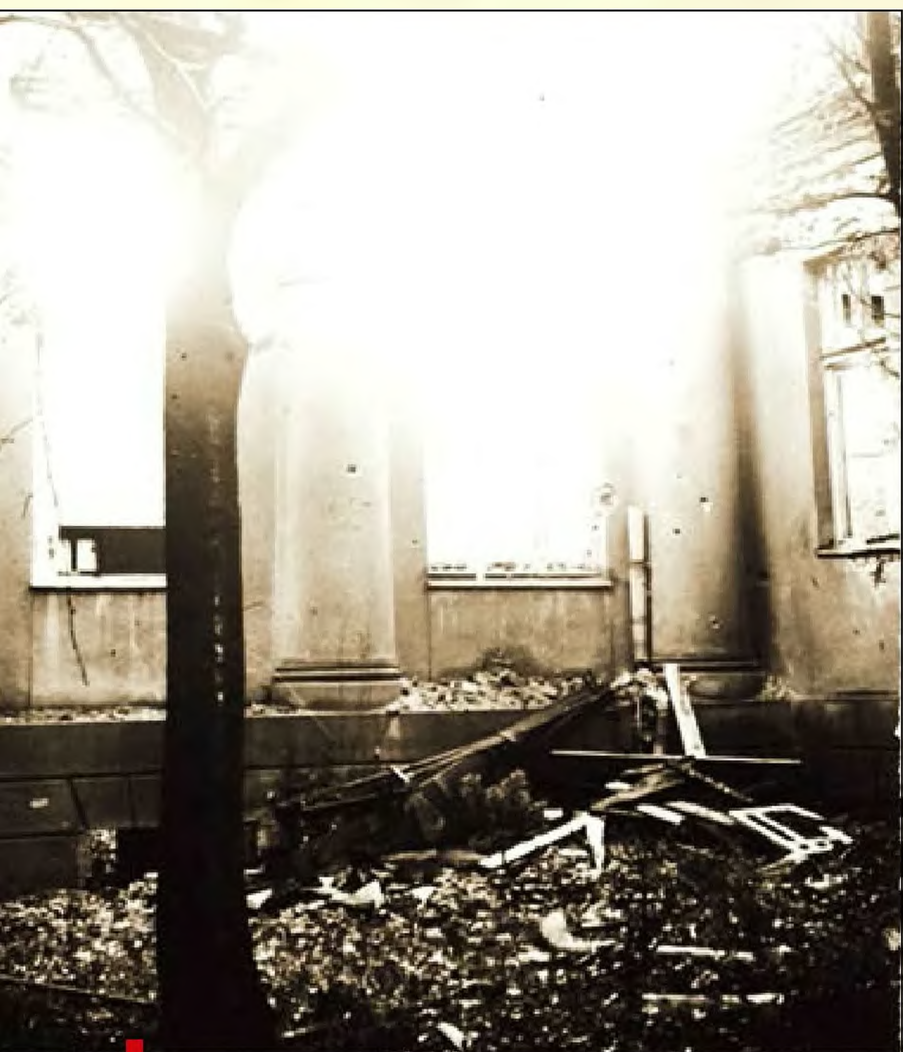
Zniszczony pawilon G
