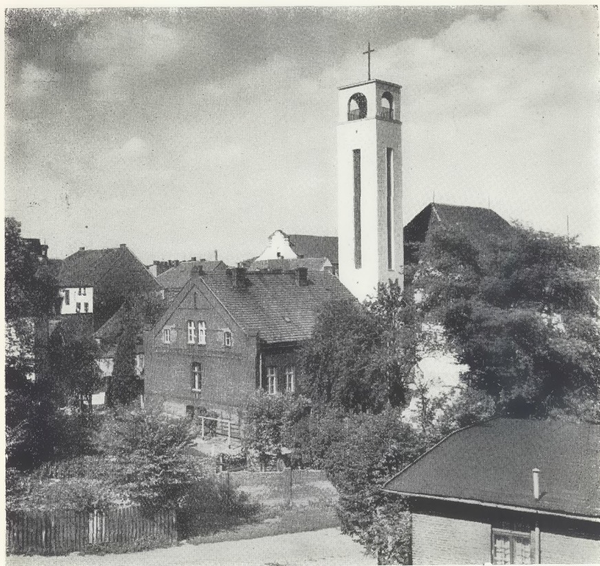
Neubau des Glockenturms und der Sakristei der Evangelischen Kirche in Cosel D/S
