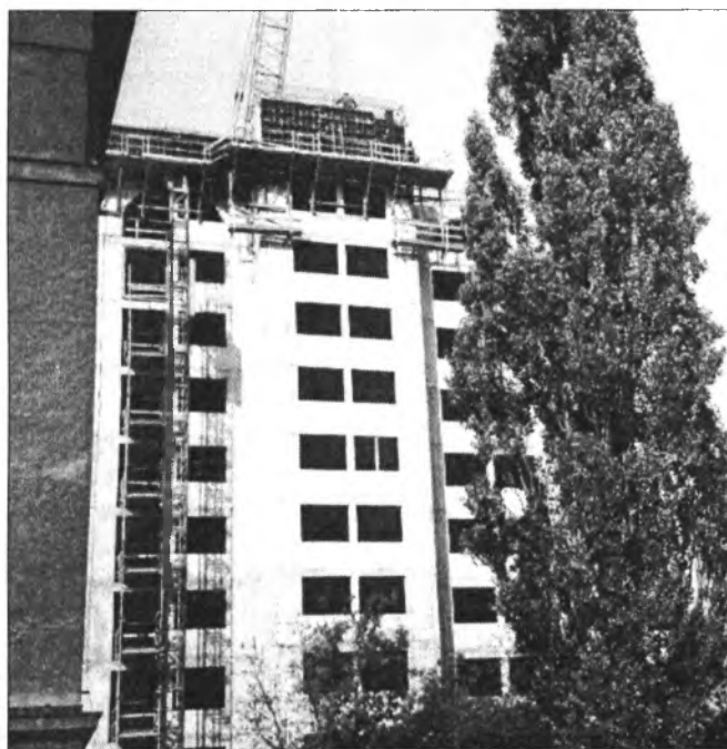
Wyrósł budynek nowego akademika.
