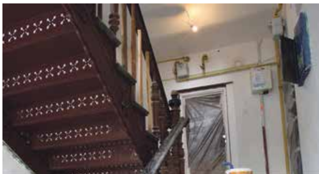
Remonty klatek schodowych trwają w budynkach przy ul. Krzyżowej 4...
