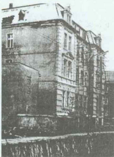
Budynek Zespołu Szkół Rolniczych przygotowany do remontu w 1979 roku.
