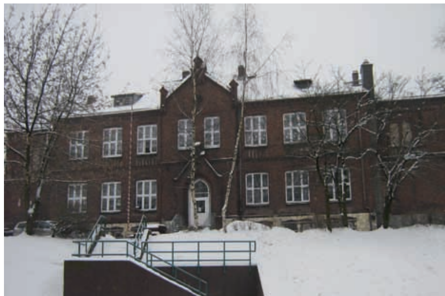
Szkoła w Porąbce. Fot. arch. autora
