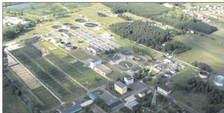
oraz eksploatacja oczyszczalni ścieków w Dźbowie, typu Superbos, dla około 2500 mieszkańców dzielnicy Dźbów
