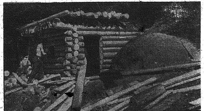
Bunker w postaci domu mieszkalnego zbudowany przez grenadierów niemieckich na froncie. podkarpacim.
