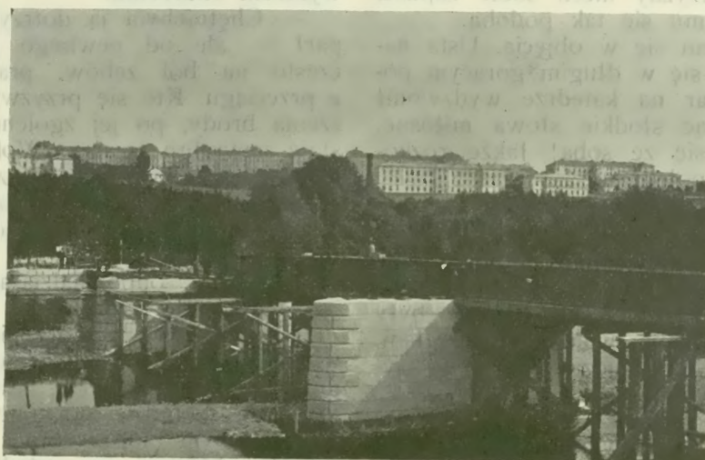
Cieszyn dawniej: Budowa mostu jubileuszowego.
