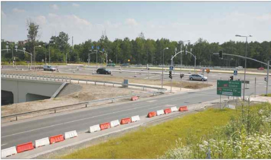
Wiadukt nad obwodnicą
