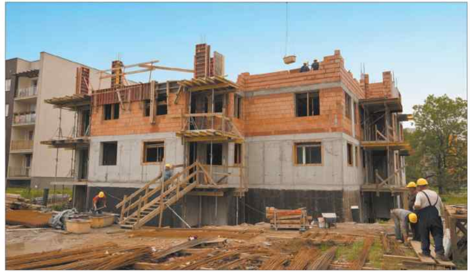
Karpacka – budowa nowych mieszkań
