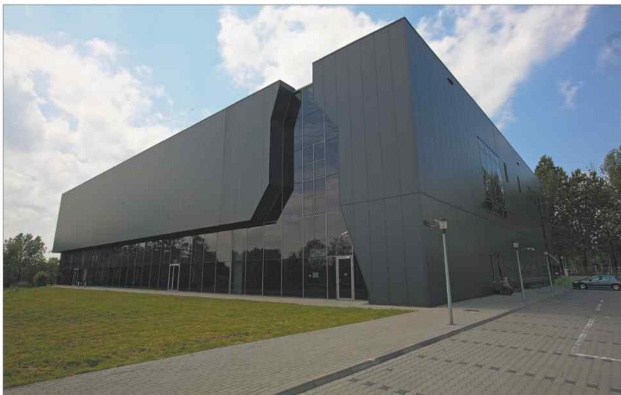
Budowa hali w Szombierkach kosztowała 20 mln zł
