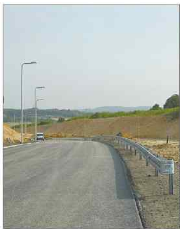
Droga w budowie, nazwa już jest.
