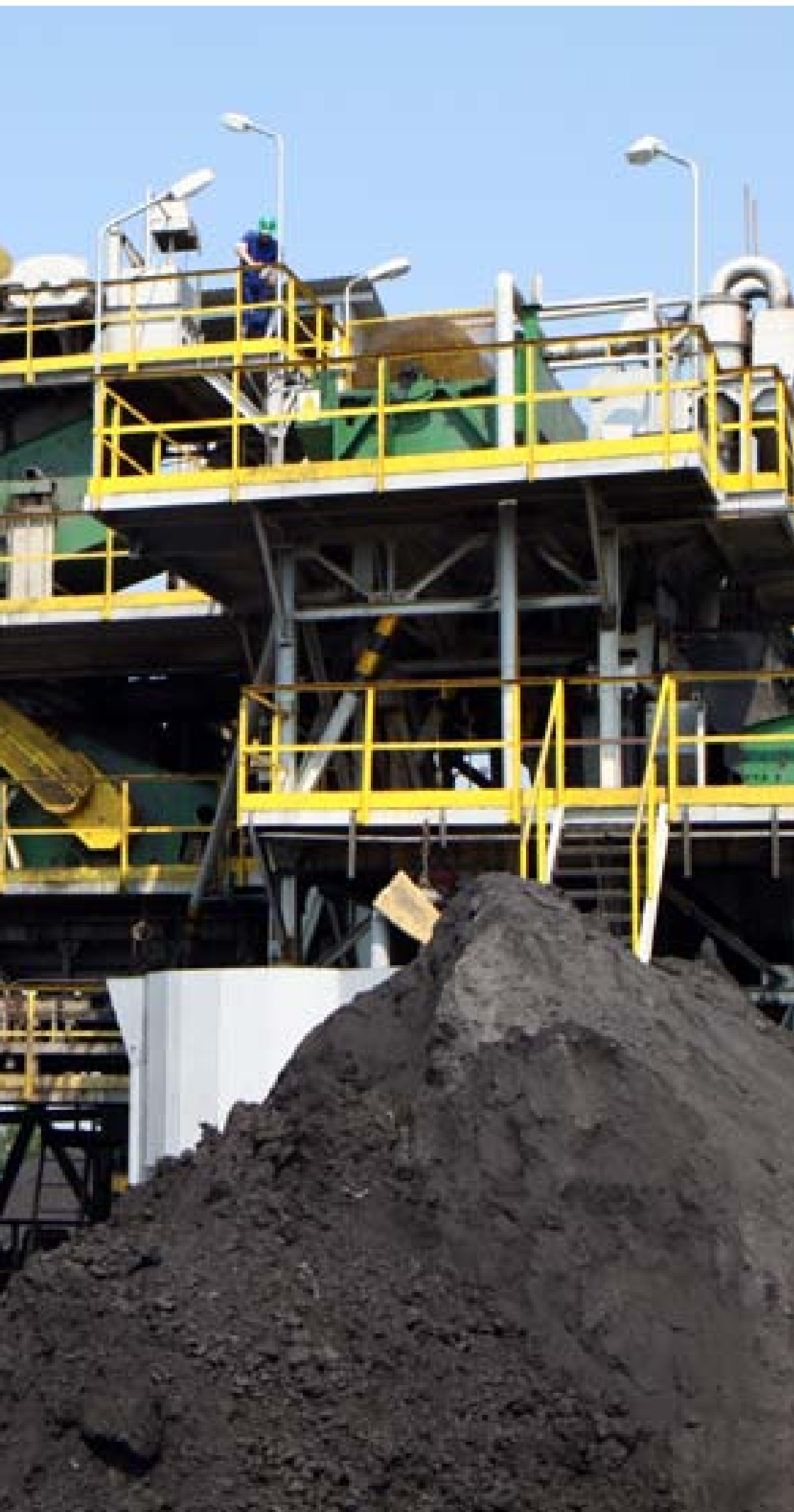
Płuczka modułowo-kontenerowa posłuży do wzbogacania odpadów wydobywczych zlokalizowanych na hałdzie
