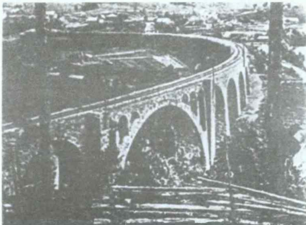
Wiadukt w Worochcie, odbudowany przez Polskie Koleje Państwowe powiat Nadwórna
