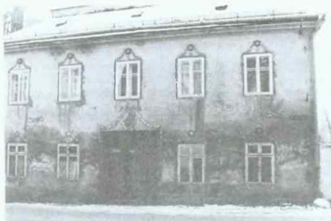
Kamienica przy skrzyżowaniu ulic Ratuszowej i Kościelnej. Fot. RAFAŁ MIELNIK Fasada Północna
