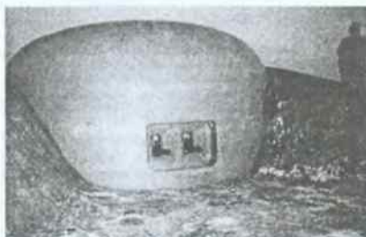
Stanowisko karabinów maszynowych tzw. "kaponiera" - niemiecki system obronny Odry i Opawicy. (widok z 1987r.)
