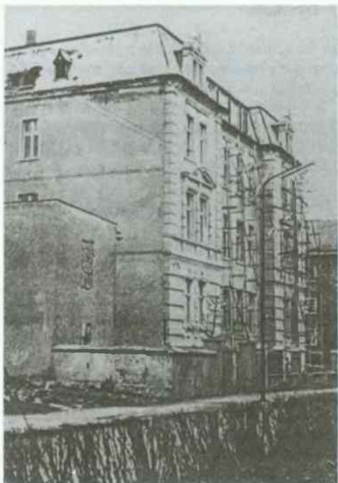
Budynek Zespołu Szkół Rolniczych przygotowywany do remontu, w 1979 r.
