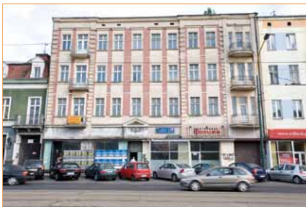
Stan dzisiejszy (przed remontem)
