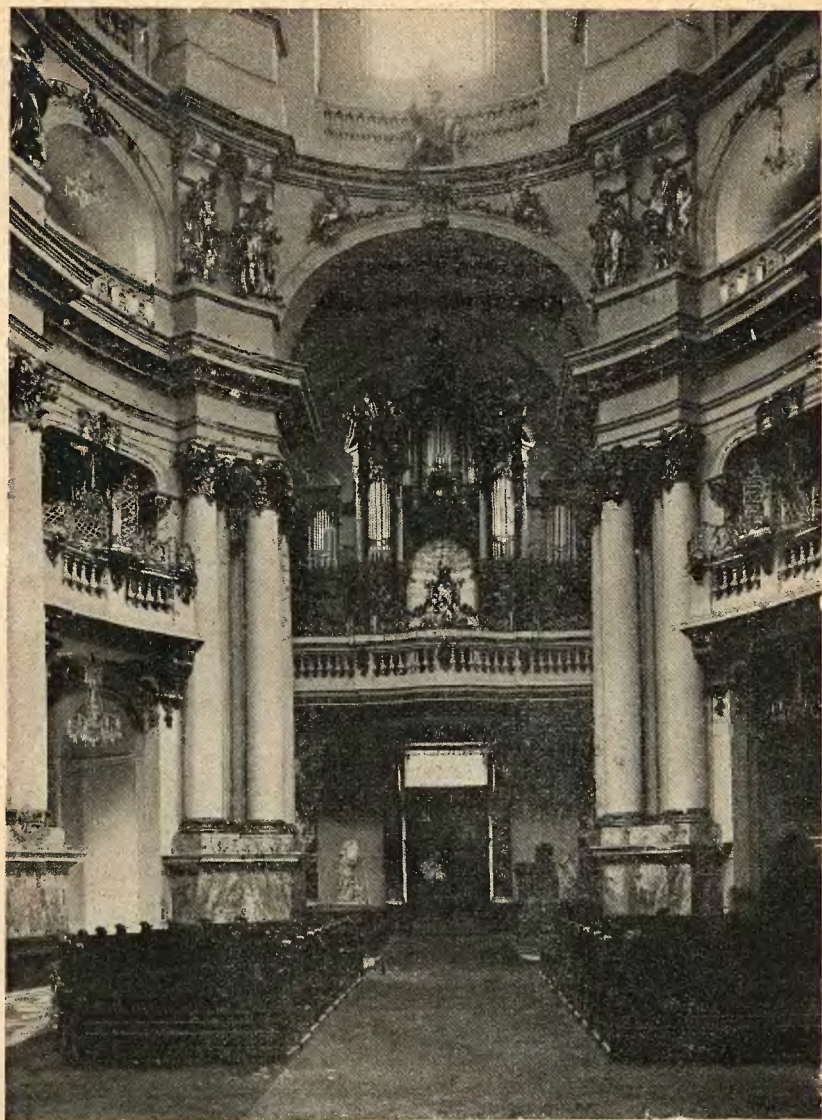
Fig. 4. Wnętrze kościoła po restauracji (widok ku chórowi muzycznemu).
