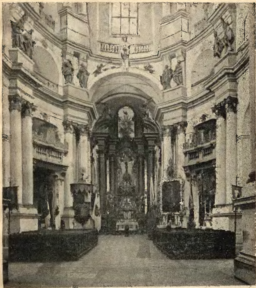
Fig. 2. Wnętrze kościoła przed restauracją.
