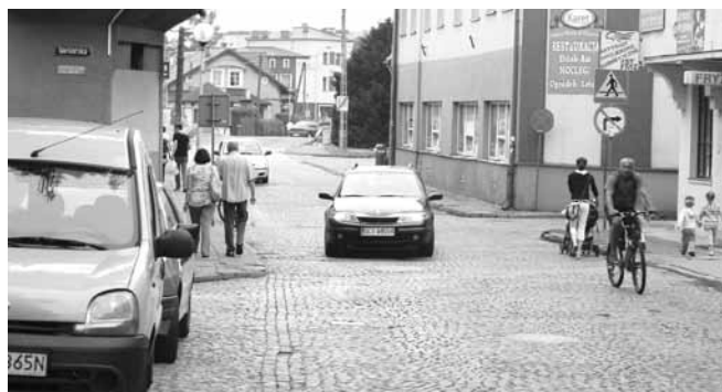
Ulica Ustrońska będzie remontowana na odcinku od rynku do mostu na Bładnicy. Fot. R. Stelmasczyk
