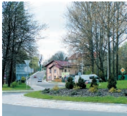
Rozpoczyna się przebudowa ul. Cieszyńskiej. Zdjęcie: imk
