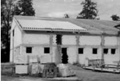
Budowa Sali Gimnastycznej przy SP 7, Foto: E. Bojda
