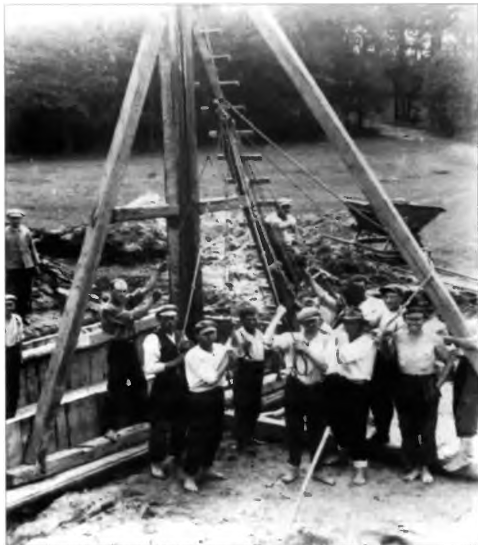
Budowa kolei Żory-Rybnik w 1936 r. (ze zbiorów A. Gamoń)
