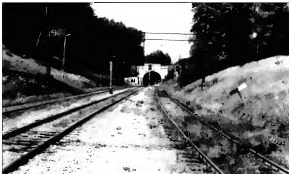
Wlot tunelu od strony stacji kolejowej w Rydułtowach. Stan z 1997 r.
