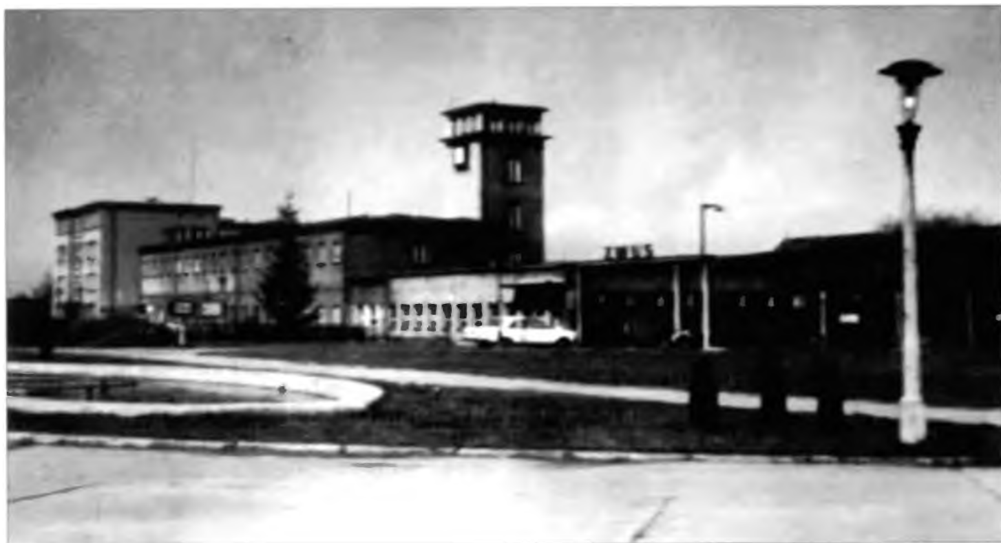
Panorama Zakładu w Żorach, lata 70. ubiegłego wieku
