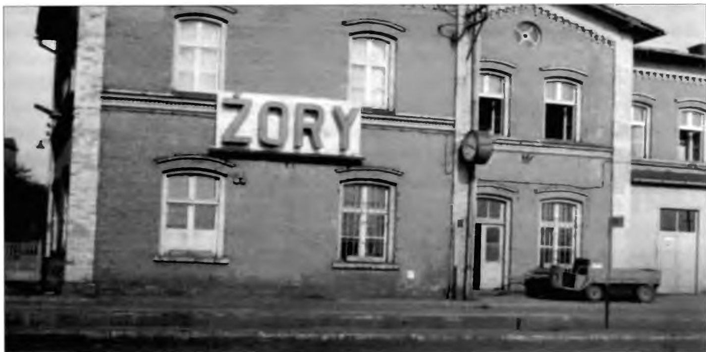
Dworzec kolejowy w Żorach przed elektryfikacją linii kolejowej
