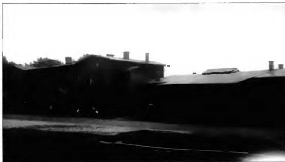
Zabudowania dworca kolejowego i ekspedycji towarowej w Żorach
