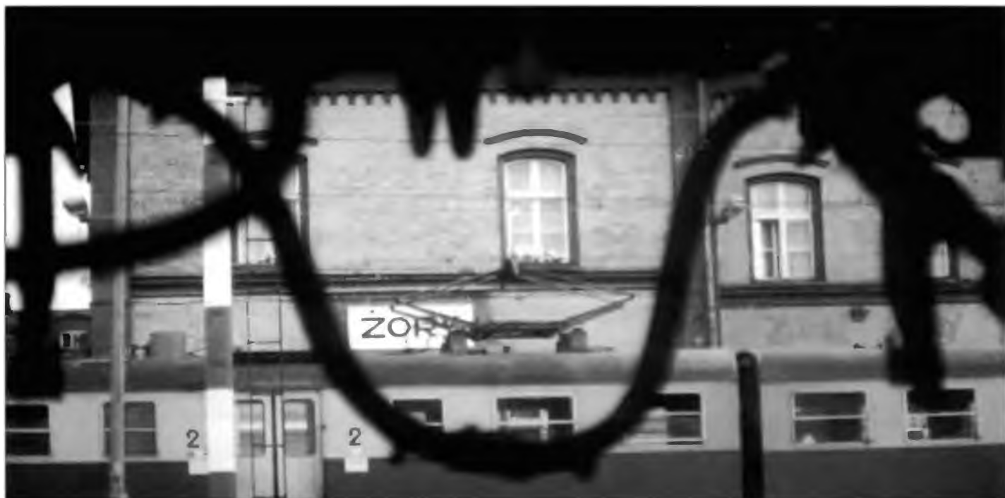
Stacja kolejowa w Żorach po elektryfikacji w 1973 r.
