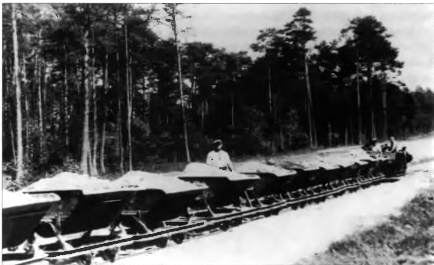
Budowa kolei Żory-Rybnik w 1936 r. (ze zbiorów A. Gamoń)
