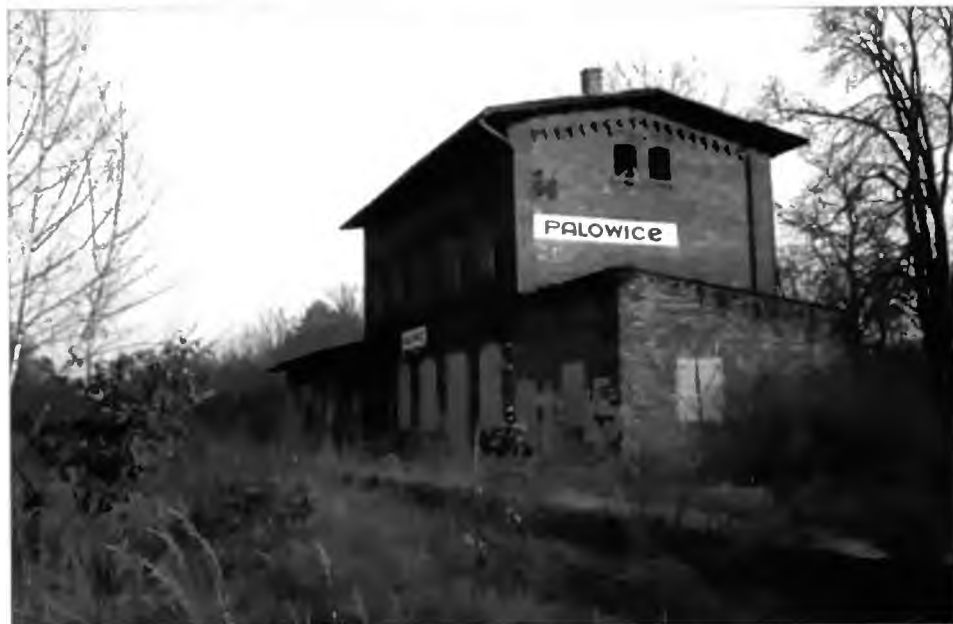
Przystanek kolejowy w Palowicach na linii Żory-Orzesze. Stan obecny
