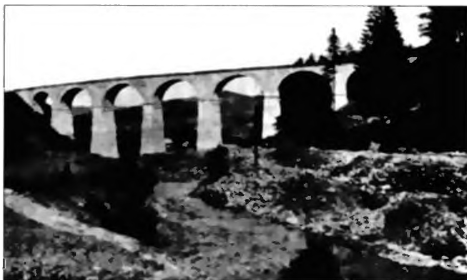
Wiadukt kolejowy nad potokiem Łabajów w Wiśle
