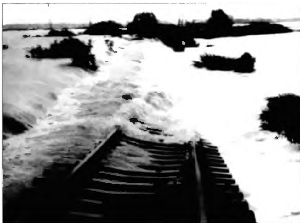
Zniszczony przez powódź tor kolejowy na trasie Belsznica-Olza (lipiec 1997), foto Jan Psota
