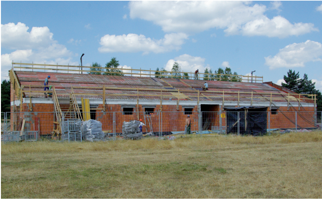
Prace przy budowie budynku socjalno - technicznego na stadionie LKS „Przemsza” Siewierz
