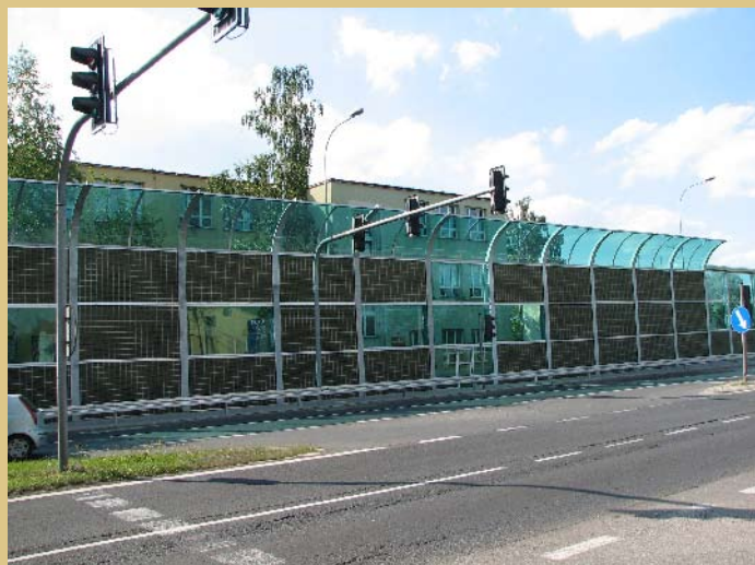
Rozpoczęto budowę ekranów akustycznych w Wojkowicach Kościelnych
