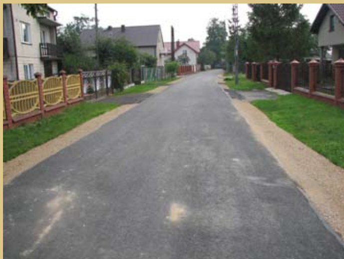
Realizowane są liczne budowy i remonty dróg i chodników (na zdjęciu ul. Różana w Wojkowicach Kościelnych)
