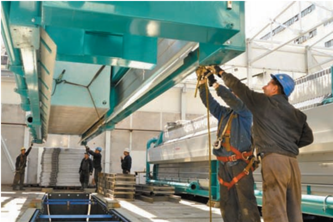
Trwa montaż nowoczesnej prasy
