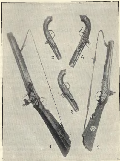
155. Strzelby i pistolety . 1. Strzelba na krzemień; łożo rzeźbione; u dolnej części jego widać schówek na kulę, z którego zdjęta zasuwka; zamek naciągnięty; pomiędzy widłami jego krzemień; przed nim sterczy stalowe ogniwo; pod nim kaganiec; cewka tej strzelby mosiężna grawirowana; waży 4-4 kg. 2. Taka sama strzelba ze zamkiem spuszczoneym. 3. 4 5. Pistolety. Własność muzeum im. Dzieduszyckich we Lwowie.
