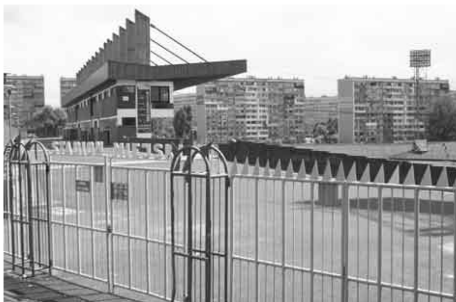
Przy stadionie miejskim powstało nowe boisko
