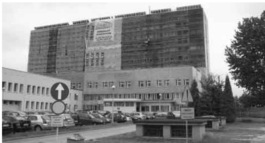
Trwa termomodernizacja bloku łóżkowego
