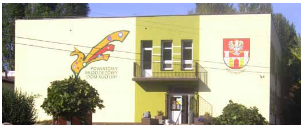
Wyremontowany budynek PMDK zaprasza na zajęcia.
