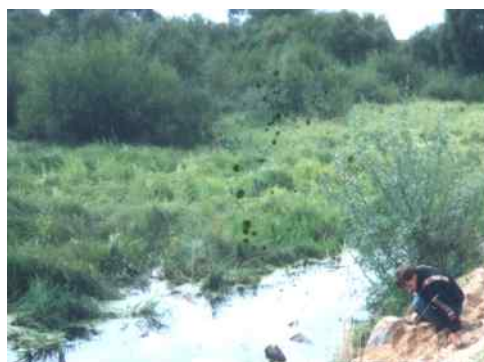
Zamiast drewnianego mostu – betonowa rura, a zamiast dość dużego stawku – kaluża
