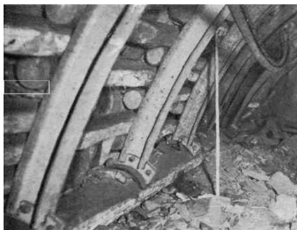
Chodnikowa obudowa typu „Moll” – wsparta na drewnianych podciągach
