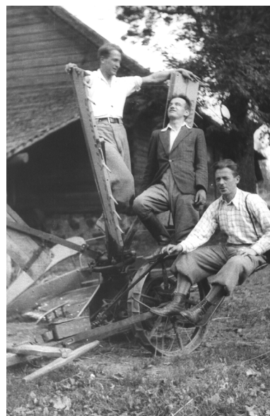
Zygmunt lubił robić zdjęcia „komponowane”. Za plecami Tadeusza widać dach powietki, pod którą w latach dzieciństwa odbywało się nasze wielkie „majsterkowanie”
