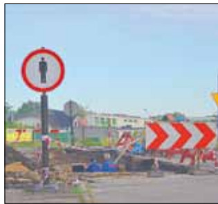
Prace w rejonie biblioteki trwają.
