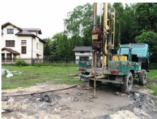
Rys. 9. Wiercenie otworu dla potrzeb uzdatnienia podłoża w 2013 r. (Fot. S. Tomecka-Suchoń)
