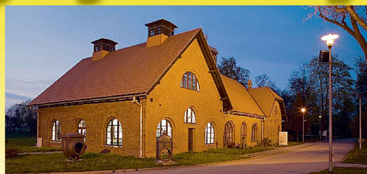
Muzeum Techniki Sanitarnej w Katowicach
