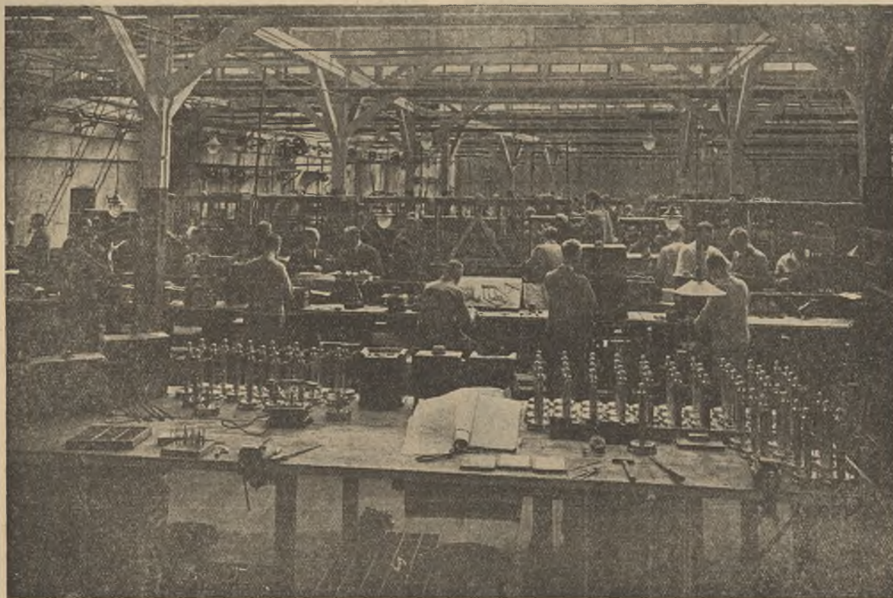
Widok częściowy działu budowy central Koncernu Priteg.
