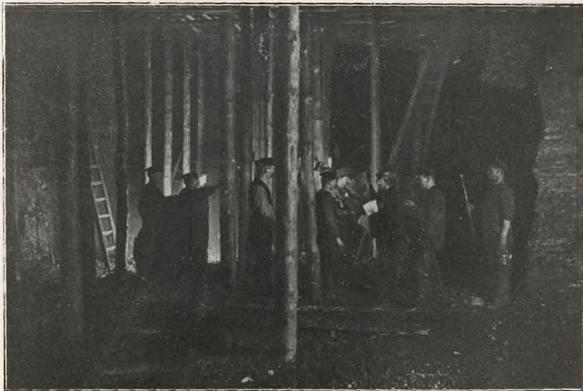
Das Bild ist aufgenommen während der Arbeit im Kohlenpfeiler des Sattelflözes der Grube Król (König) Ostfeld und zeigt deutlich die Mächtigkeit dieses Flözes, welche stellenweise 8 mtr. erreicht. Die auf der Photographie ersichtlich. Stempel stützen die Firste während der Hereingewinnung der Kohle.
