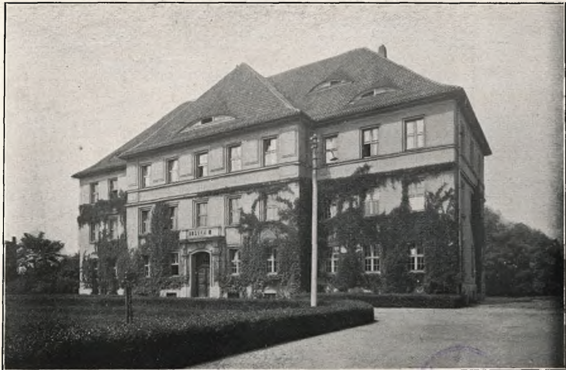
Gruben- direktionsgebäude in Knurów.
