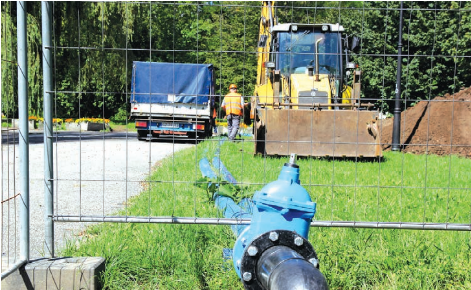
Po wyczyszczeniu sieci zastępcza rura zostanie usunięta.
