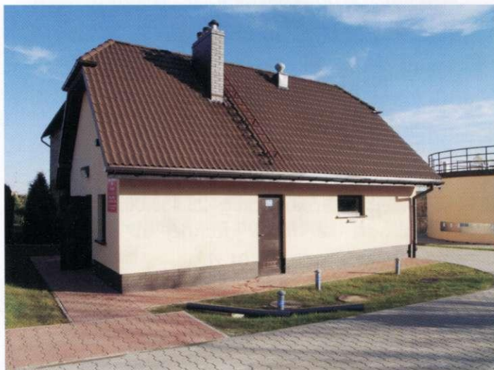
Stacja Uzdatniania Wody w Pstrążnej
