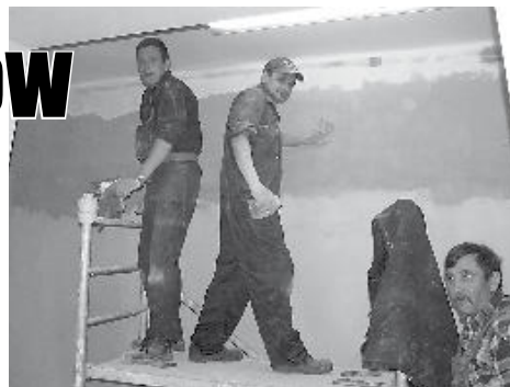
Ekipa remontowa wykańcza wnętrze holu budynku przy ul. Staszica 1
